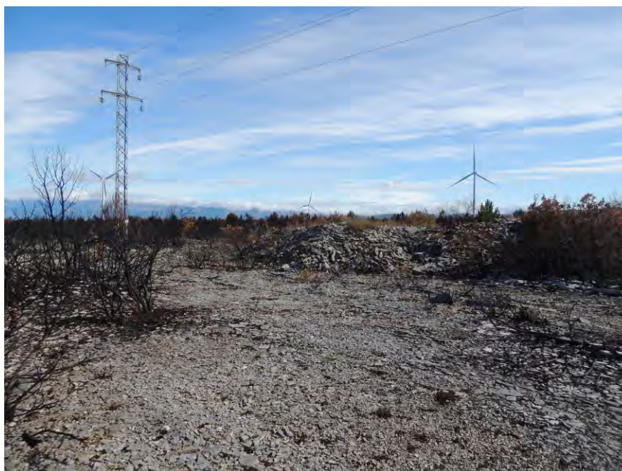
Slika 9. Lokacija zahvata – postojeće stanje
